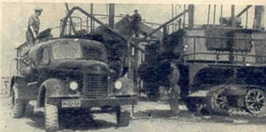
Отечественные заводы снабжают строителей газопроводов передовой техникой.
